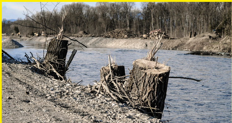
Murufer nach Schlägerungen (Foto vom Kraftwerk Gössendorf)
