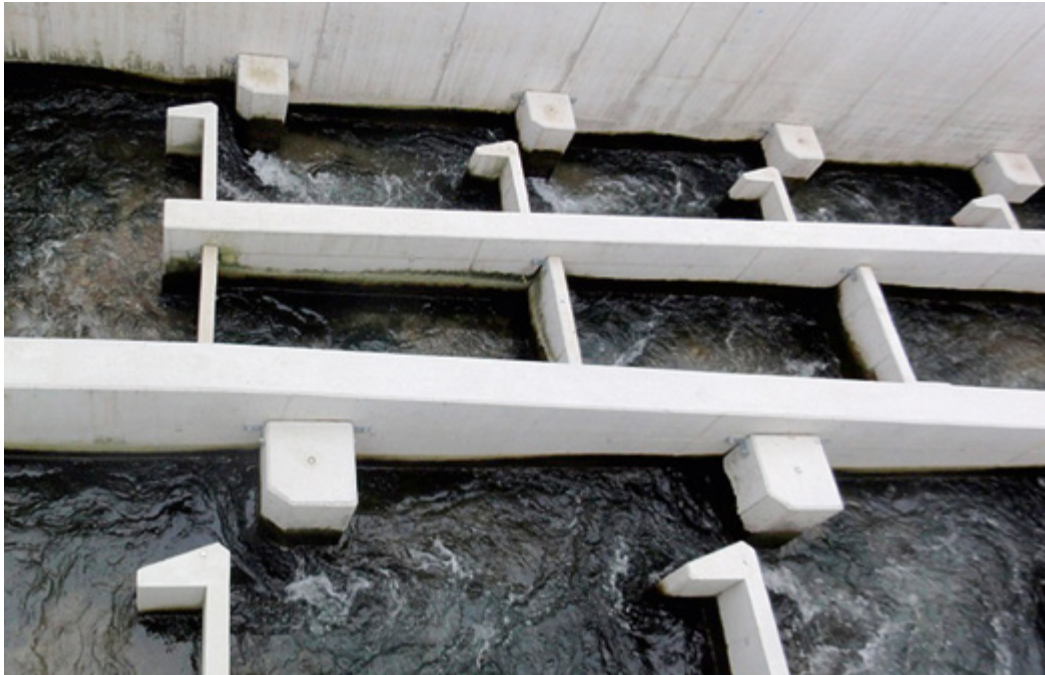
Wesentliche Nachteile des klassischen, technischen FAH Bautyps „Schlitzpass (Vertical Slot)“ sind in der Regel hohe Errichtungskosten, eine verstärkte Neigung zur Verkläusung und die fehlende Lebensraumeignung. (Beispiel hier: Ybbs, 500 l/s)
